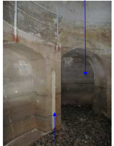
Entrée de la galerie d'évacuation
